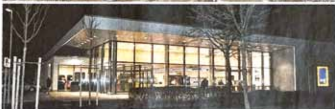
Sie setzten den ersten Spatenstich gemeinsam: Bäuleiter Markus Weber (v. l.), Regionalverkaufsleiter Tristan Poser, Architektin Michaela von Baumgarten, OB Dr. Bernd Pöhl, Expansionsleiter Nils Reitzmann, Stadtbaumeister Mathias Welle und Ingenieur Claus Fiebig. Unten: die einzige illethel gebaute Filiale von Aldi Süd bei München in einer Nachtsicht. BILDEN: LEHMANNS/ALDI SÜD
