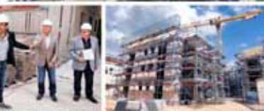
Baubeginnung mit Oberbürgermeister Dr. Ralf Pohl, FWV-Geschäftsführer Hans-Joachim Kahlert, Stadtbaumeister Hans-Walter Wille und FWV-Bauleiter Prof. Dr. Ralf Pohl (vorne links) an der Karlsruher Straße auf Höhe des ehemaligen Granitzky-Areals. Im Hintergrund sind die Fortschritte des Projekts deutlich.
